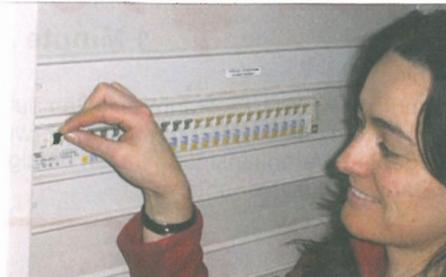
Alle Fehlerstromschutzschalter sind mit einer Prüftaste ausgestattet, die einen Funktionstest erlaubt.
