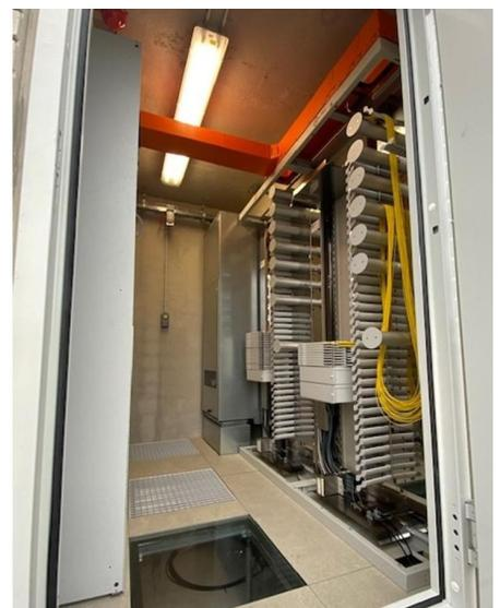
*Innenansicht der Verteilerstation—Hier werden die Fasern beleuchtet.*
