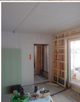
Isolieren. Dadurch konnten wir auch in der kalten Jahreszeit den Innenausbau angehen. In insgesamt 5 Wochen wurden jeweils am Abend die Rigipsplatten angebracht, Elektroschläuche und Kabel gezogen und Abflüsse sowie Wasserleitungen installiert. Mittlerweile ist auch der Estrich verlegt. Insgesamt wurde in diesem Bauabschnitt nochmals ca. 700 freiwillige Helferstunden geleistet,
